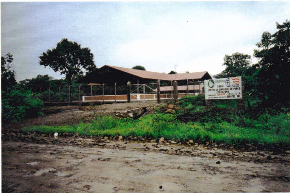
Centro de Empaque de Pinas construido por USAID
